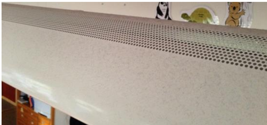
Figur 9. Damm ansamlas lätt på hög höjd, så som uppe på hängande armaturer
